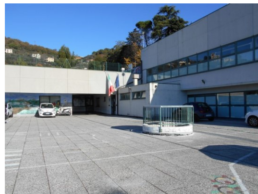
Figura 1.1 - Particolare della facciata principale e del manto stradale adibito a parcheggio
