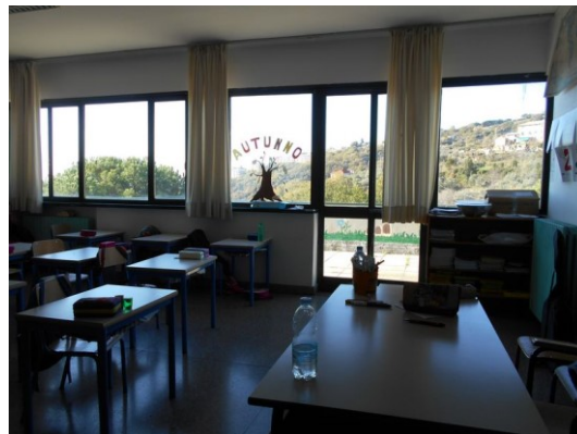
Figura 2.1 - Particolare dei serramenti di un’aula
