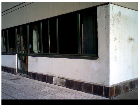
Figura 2.4 – Rilievo termografico dei serramenti
