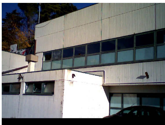
Figura 1.2 – Rilievo termografico della parete
