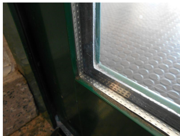
Figura 2.3 - Particolare dei serramenti – dettaglio angolo vetro
